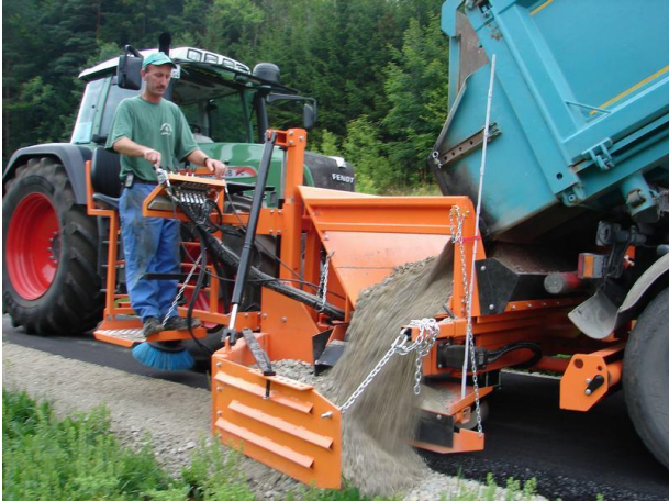
Układarka poboczy BF 290 PUSH zamontowana na traktorze
